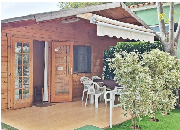
Vue de l'extérieur
